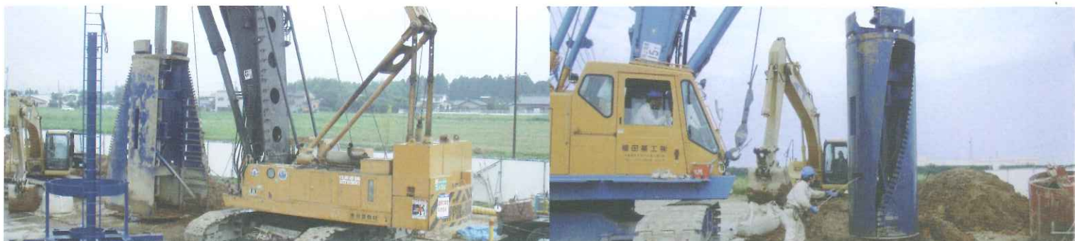
専用スライム処理機使用状況 (軸径φ2,100、拡底径φ4,700)
