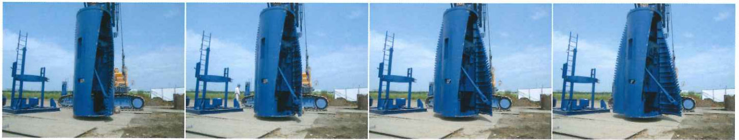
拡底バケットの作動状況
