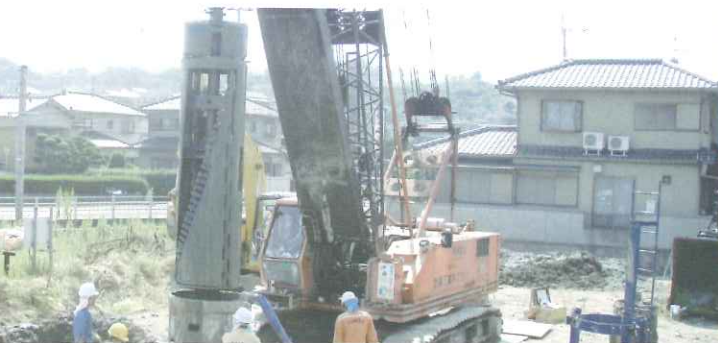
傾斜角20°用に改造したバケット(SY-1023バケット)
